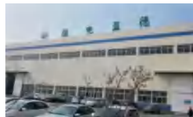
青岛国电蓝德环境工程有限公司 多款计量泵及成套化学加药装置在国电蓝德项目中成功使用。
