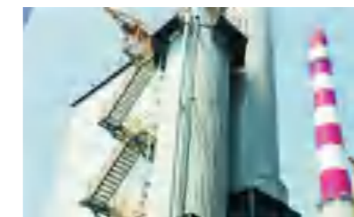
杭州杭联热电
